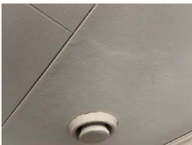
Fuktskadet takplate
