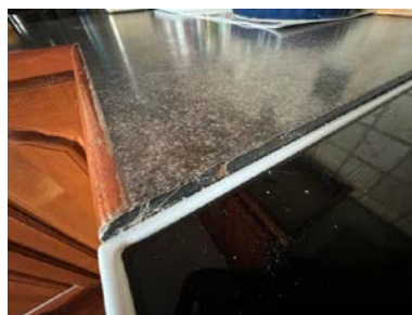
Skader på side benkeplate ved komfyr
