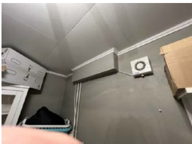
Innkasset fordeling av rør i rør.
