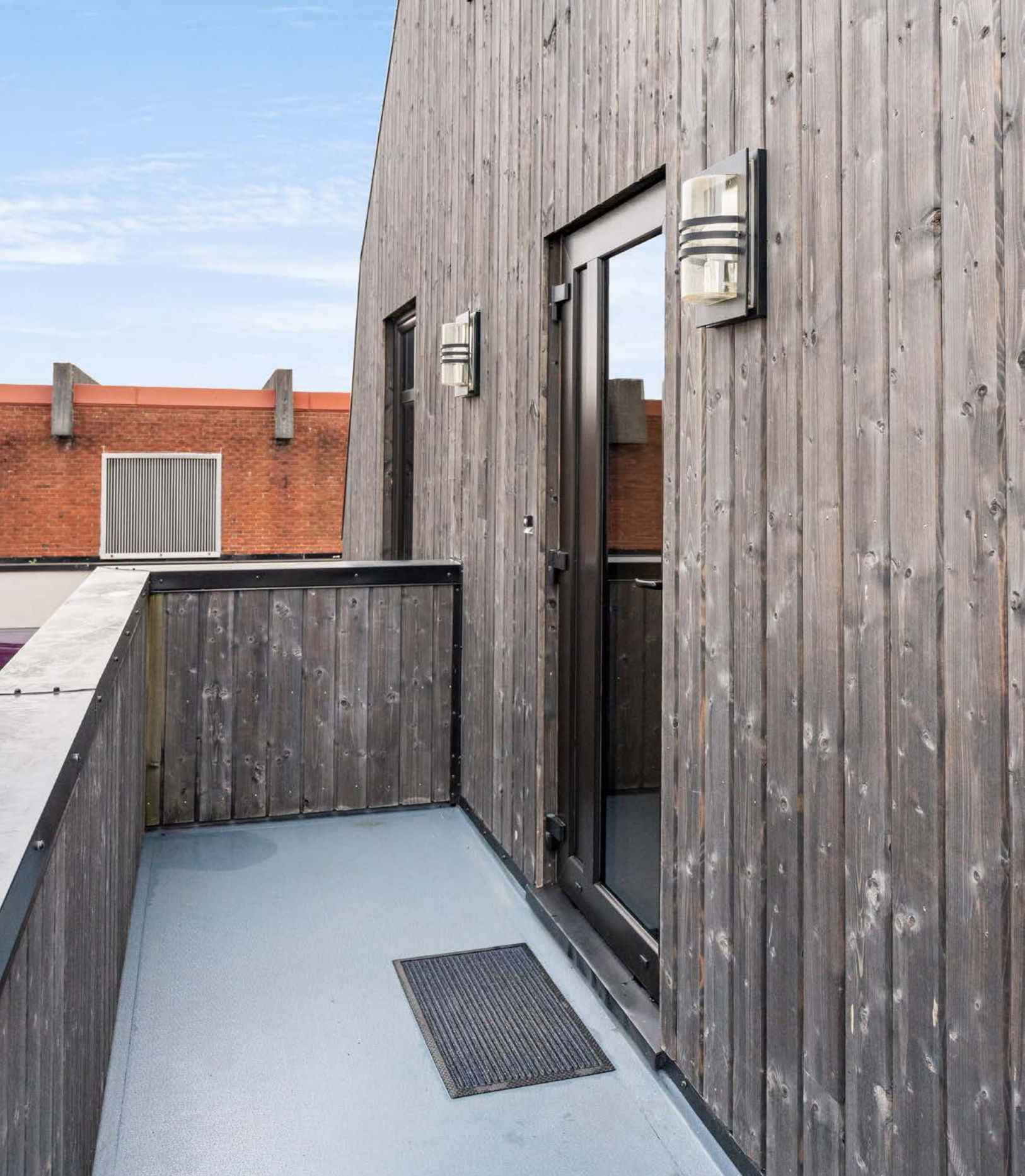
Inngangspartiet til leilighet i 3. etasje.
