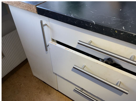
Benkeplate mangler endestykke og skader på innredning.
