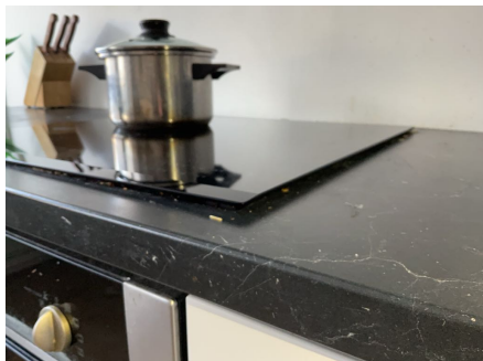
Benkeplate mangler endestykke og skader på innredning.
