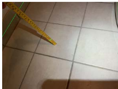
Bom/hullyd registrert på flis.
