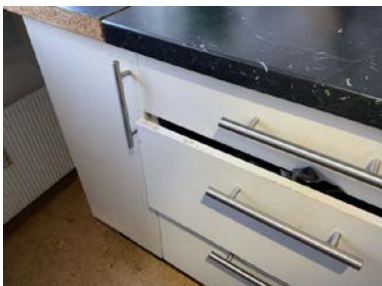
Benkeplate mangler endestykke og skader på innredning.
