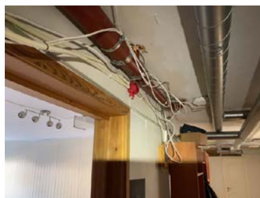
Ufagmessig ledningføring.
