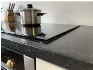
Benkeplate mangler endestykke og skader på innredning.
