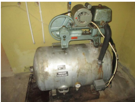
Eldre pumpe til brønnvann.
