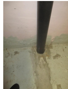
Eldre soilrør i fra hovedetasjen og loftet.
