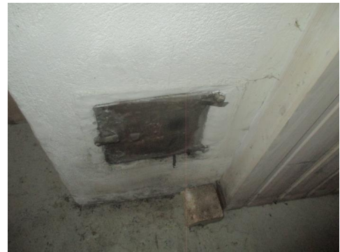
Sotluke i gangen kjeller. (Nær brennbart)
