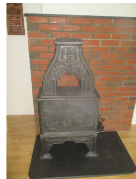
Sotluke i gangen kjeller. (Nær brennbart)
