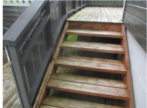
Trapp til terrasse
