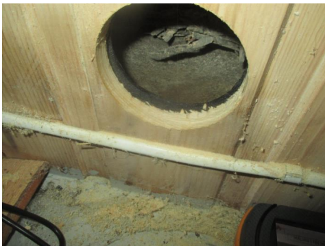
Hulltaking i ytterhjørne av kjellerstue.
