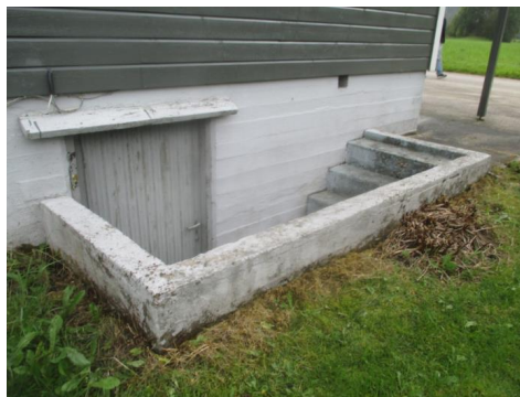
Forstøtningsmur i rundt trapp.
