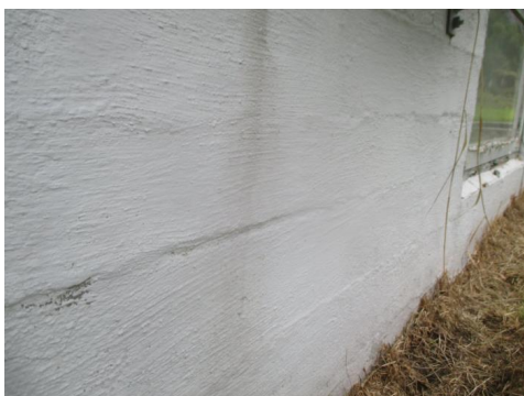
Deler av grunnmur opprinnelig del.
