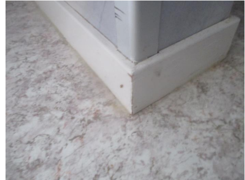
Gulvlister og flatt gulv.
