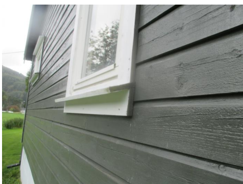
Deler av kledningen med tilhørende belistninger.
