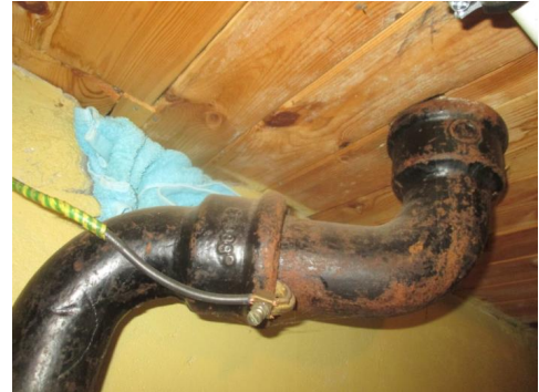
Eldre soilrør i fra hovedetasjen og loftet.
