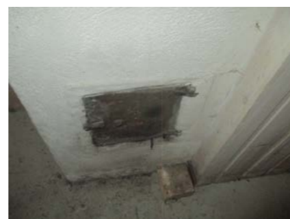
Sotluke i gangen kjeller. (Nær brennbart)
