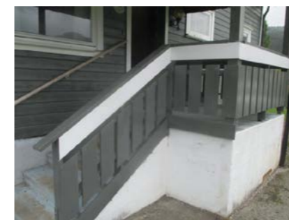
Støpt trapp med repos ved inngangsparti.
