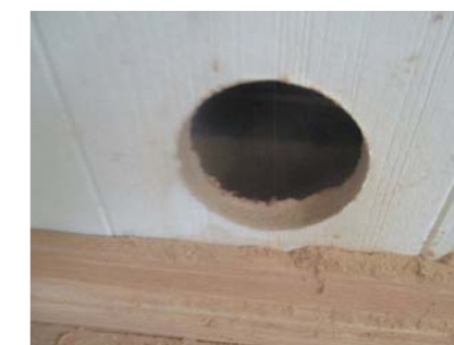
Hulltaking i fra soverommet.
