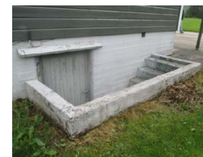
Forstøtningsmur i rundt trapp.
