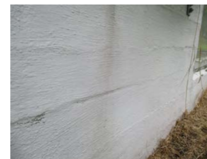
Deler av grunnmur opprinnelig del.
