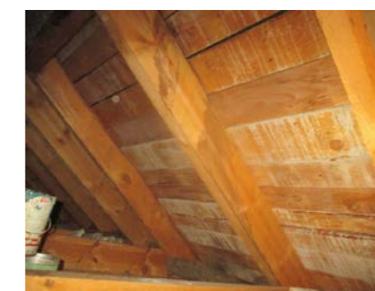
Deler av takkonstruksjonen.
