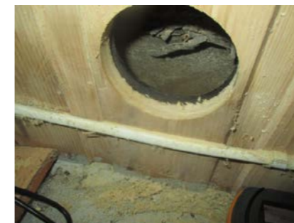
Hulltaking i ytterhjørne av kjellerstue.
