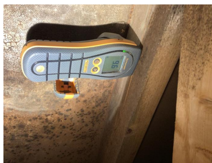
Ved fuktmåling registrerte jeg tørre verdier.
