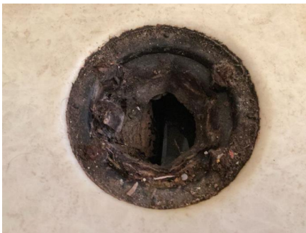
Skade / hull i gulvbelegg.
