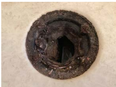
Skade / hull i gulvbelegg.
