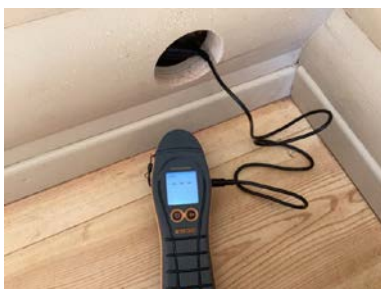
Ved fuktmåling ble det registrert tørre verdier (under 12%).
