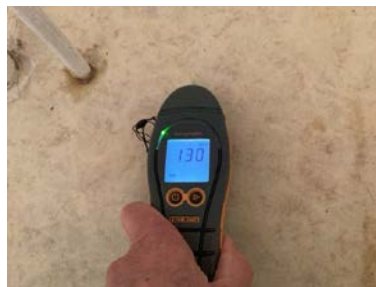
Ved enkle fuktsøk ble det ikke registrert unormale verdier.
