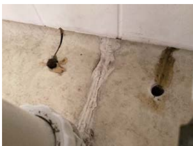
Skade / hull i gulvbelegg.
