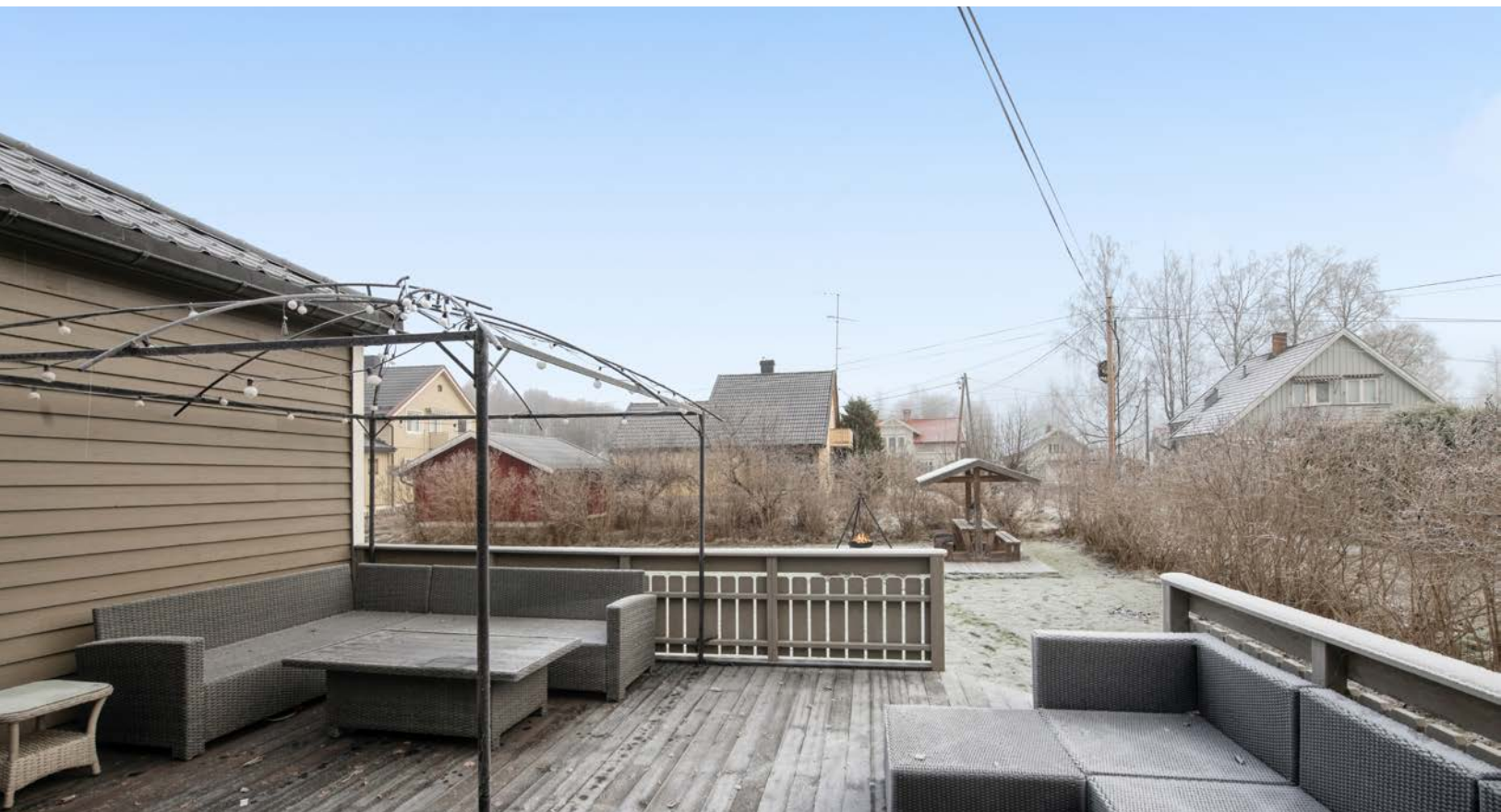
Terrassen ble bygget ny i 2012.
