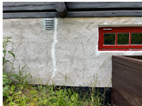
Forseglet sprekk/riss i grunnmur.
