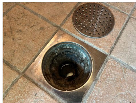
Sluk uten synlig membranmansjett.
