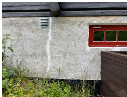
Forseglet sprekk/riss i grunnmur.
