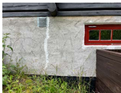
Forseglet sprekk/riss i grunnmur.
