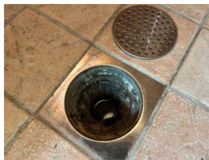
Sluk uten synlig membranmansjett.
