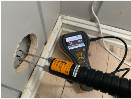
Fuktmåling i vegg ved hulltaking.
