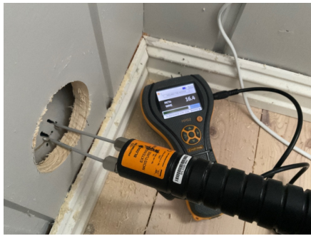
Fuktmåling i vegg ved hulltaking.
