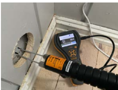
Fuktmåling i vegg ved hulltaking.
