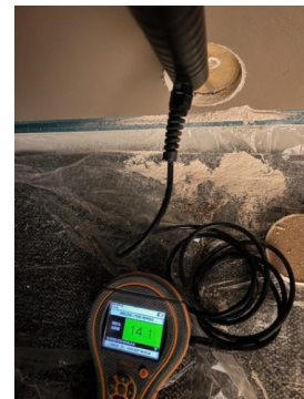
Fuktmåling i påforet betongvegg mot terreng.
