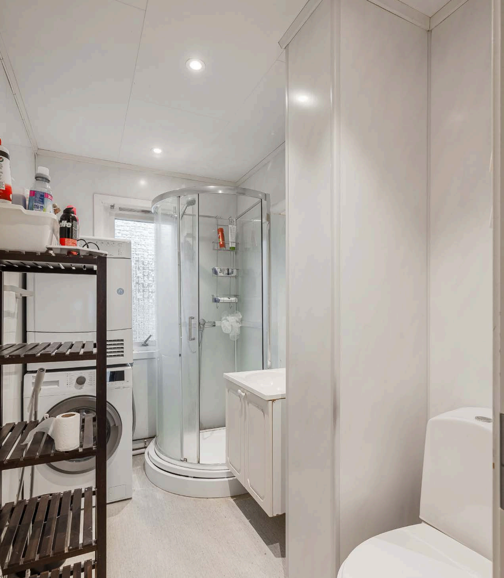
Bad/vaskerom med ukjent alder, antatt modernisert etter 2000. Baderommet har våtromsbelegg på gulv, våtromsplater på veggene, downlights i himlingen og elektrisk styrt vifte.
