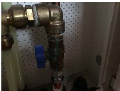
Noe irr på rør i skap
