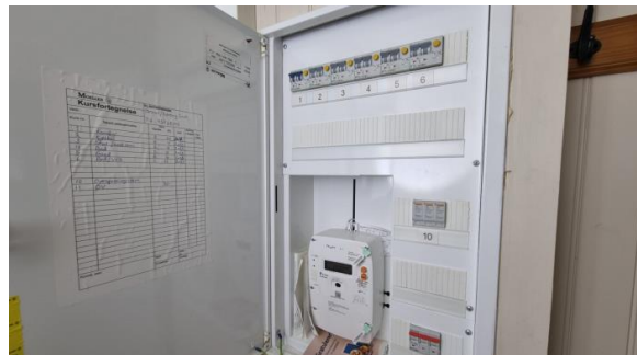
Kontroll av el-skabet i kjelleretasje.
