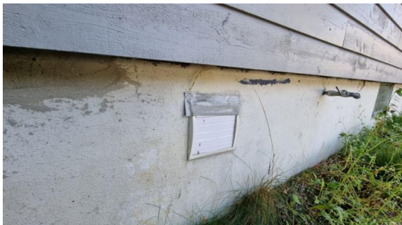
Grunnmursplast og klemlist ligger under terrenget.
