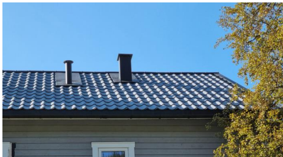
Visuell besiktigelse av taktekte.
