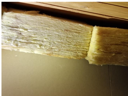
Besiktigelse av luftespalte mellom isolasjon og taktro.
