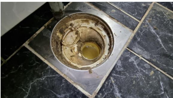
Kontroll av sluk.
