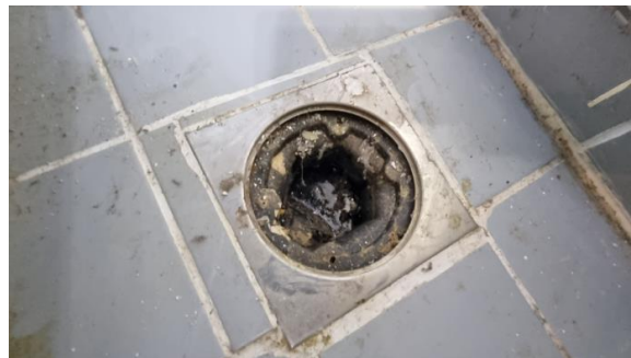
Kontroll av sluk.
