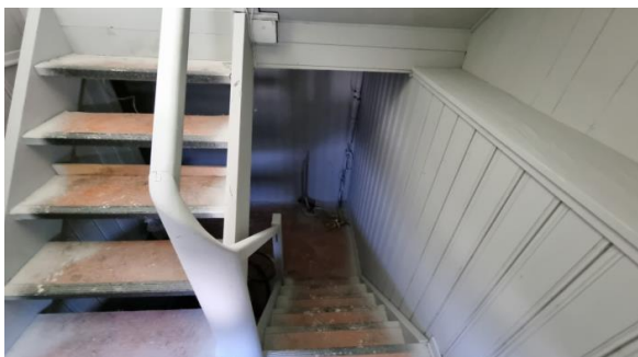
Trapp mellom 1. etasje og kjelleretasje.
