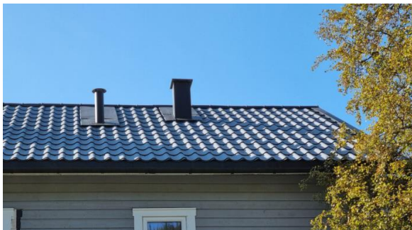
Visuell besiktigelse av taktekte.
