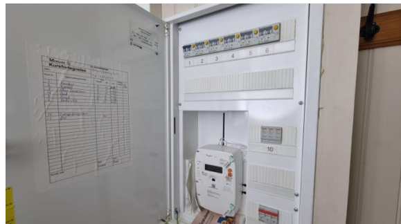
Kontroll av el-skabet i kjelleretasje.
