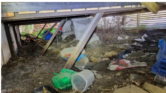
Kneker av metall og fundamenter av lettklinkerblokker.
