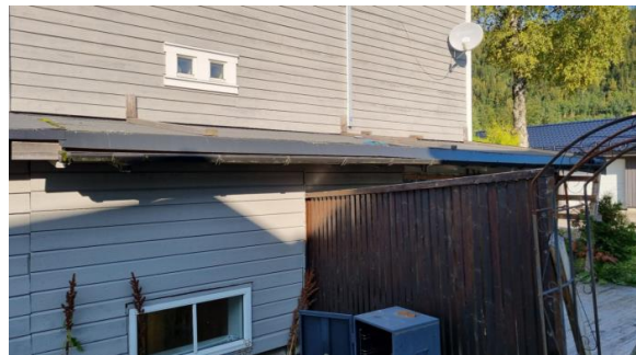
Tak er tekket med takpapp.
