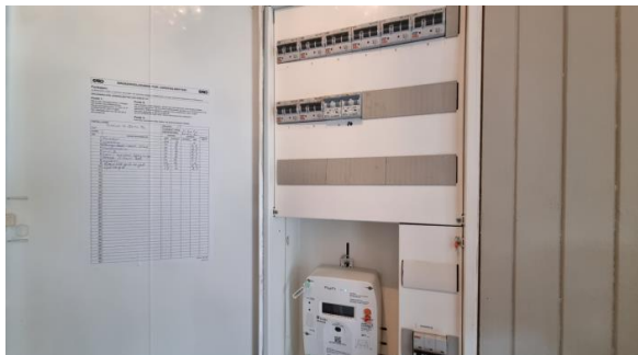
Kontroll av el-skabet i 1. etasje.
