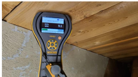
Det ble fuktmålt ved befaring, ingen unormale verdier ble registrert.
