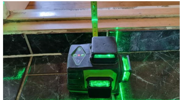
Kontroll av fall.
