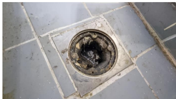
Kontroll av sluk.
