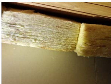
Besiktigelse av luftespalte mellom isolasjon og taktro.
