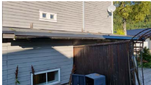
Tak er tekket med takpapp.
