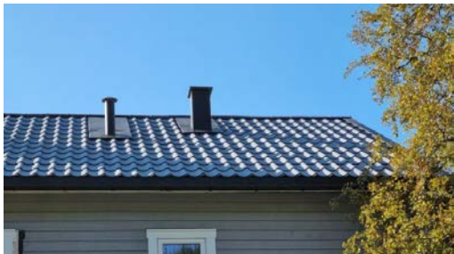
Visuell besiktigelse av taktekke.
