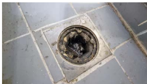
Kontroll av sluk.
