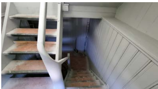
Trapp mellom 1. etasje og kjelleretasje.
