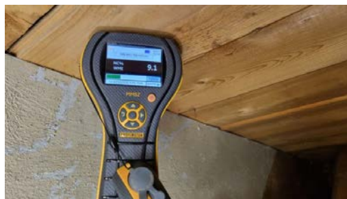
Det ble fuktmålt ved befarings, ingen unormale verdier ble registrert.
