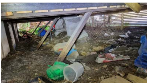
Kneker av metall og fundamenter av lettklinkerblokker.
