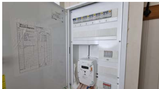
Kontroll av el-skabet i kjelleretasje.
