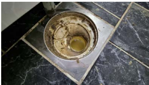
Kontroll av sluk.
