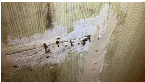
Fuktskadet veggplate.
