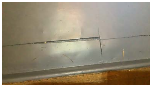
Skadet gulvbeleggflis.
