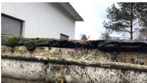
Råteskadet taktro.
