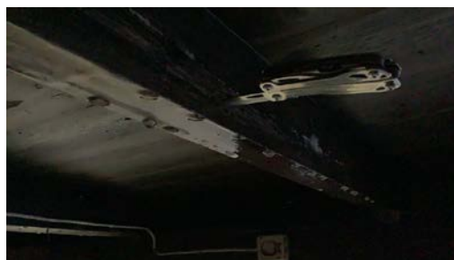
Råteskadet taksperre.
