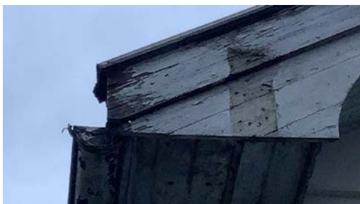
Råteskadet vindski.
