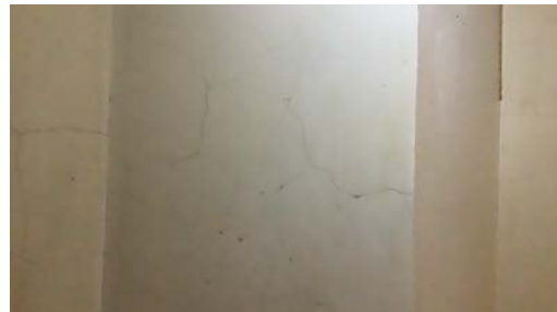
Eksempler på riss i pipe.
