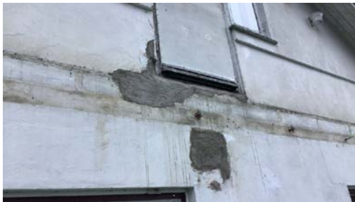
Eksempel på ubehandlet puss.
