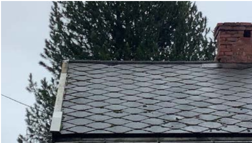
Skiferplate mangler mot vest.
