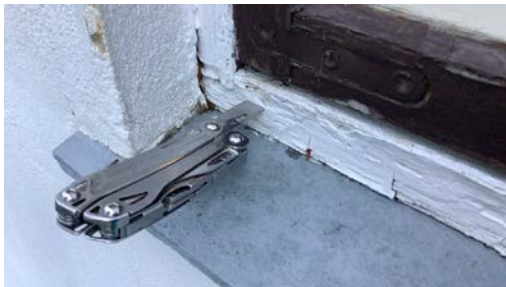
Råteskadet vindu.
