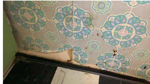
Skadet tapet.
