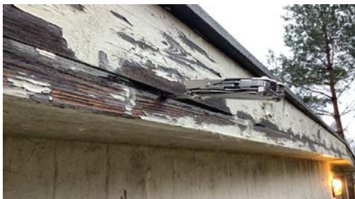
Råteskadet vindski.
