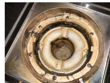
Sluk på befaringdagen.
