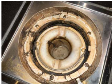
Sluk på befaringsdagen.
