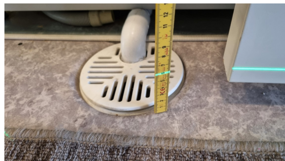
Kontroll av fall.
