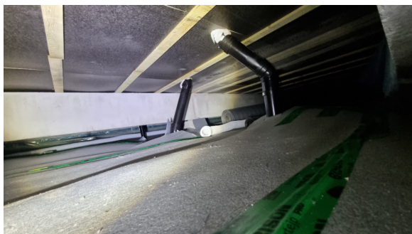
Besiktigelse av avløpsrør i krypkjeller.
