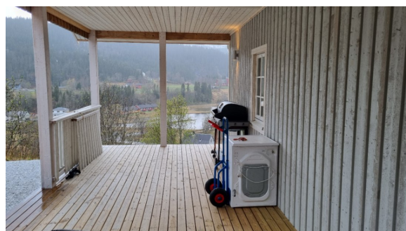
Ved befaring var ikke rekkverket montert, men rekkverket følger med boligen.
