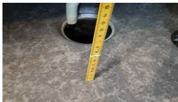
Kontroll av fall til sluk.
