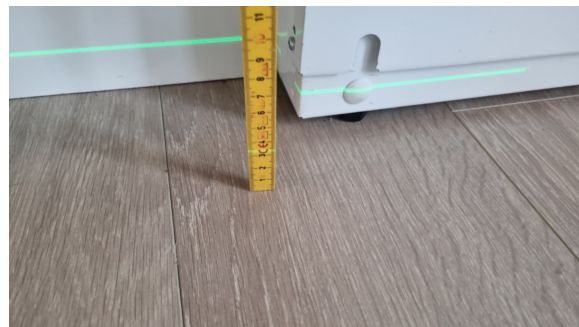
Kontroll av planavvik.
