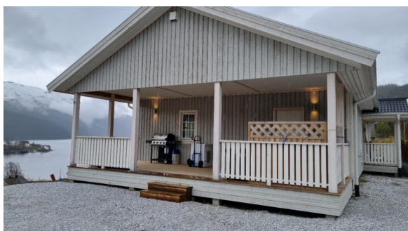
Sørvestvendt, takoverbygget terrasse.
