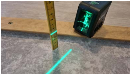
Kontroll av fall til sluk.
