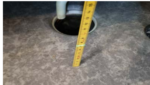
Kontroll av fall til sluk.
