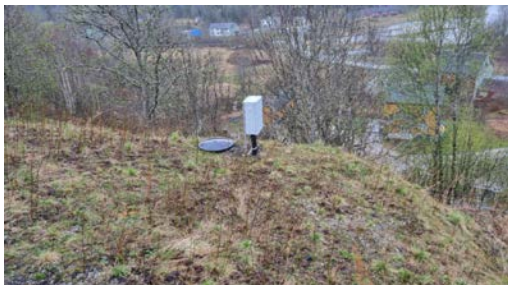
Boligen har septiktank med renseanlegg.
