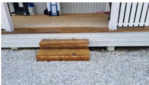
Trapp til terrasse.
