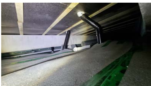
Besiktigelse av avløpsrør i krypkjeller.
