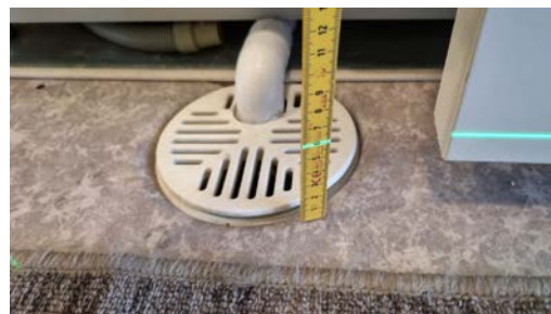
Kontroll av fall.
