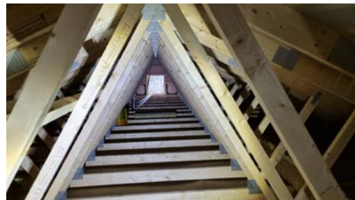
Adkomst til kaldloft via luke i gavlvegg.
