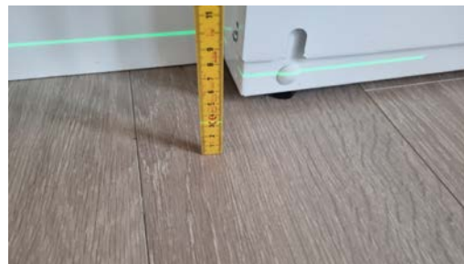
Kontroll av planavvik.
