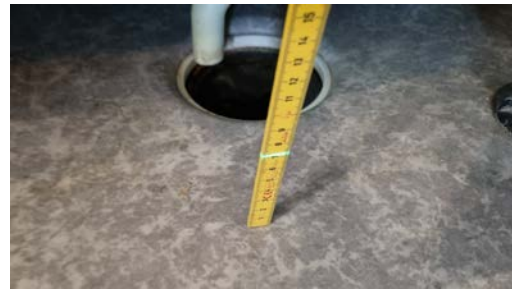
Kontroll av fall til sluk.
