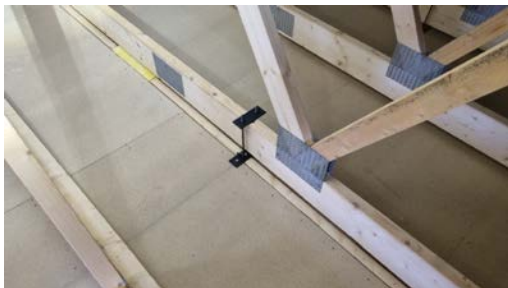
Takkonstruksjonen har nedhengt himling.
