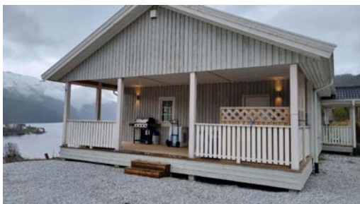
Sørvestvendt, takoverbygget terrasse.
