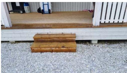
Trapp til terrasse.
