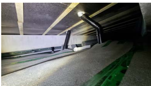
Besiktigelse av avløpsrør i krypkjeller.
