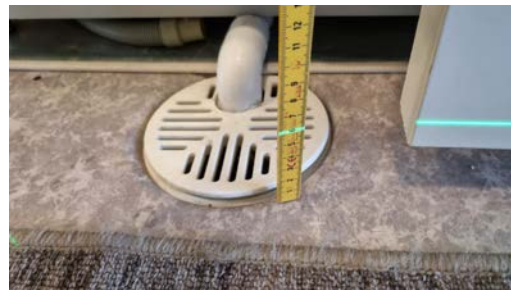
Kontroll av fall.
