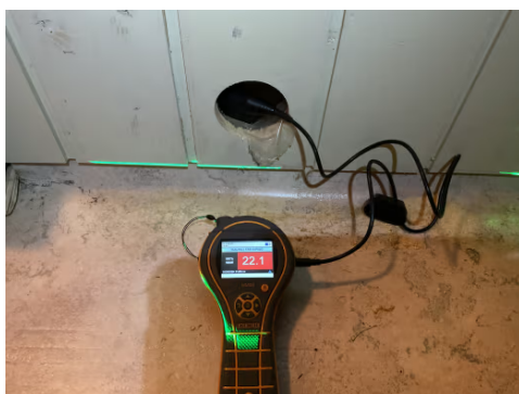
Hulltaking i tilstøtende rom.
