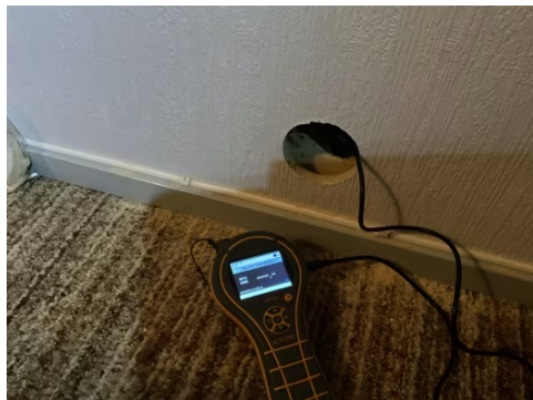
Hulltaking i tilstøtende rom.
