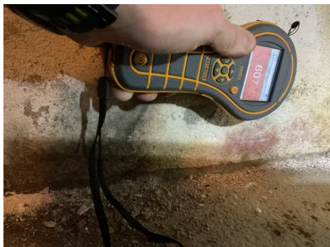
Måling på vegger i kjeller.
