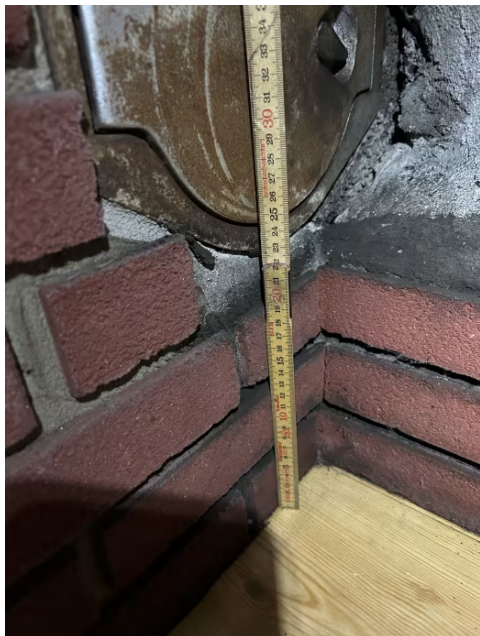
Avstand til brennbart ved sotluke.
