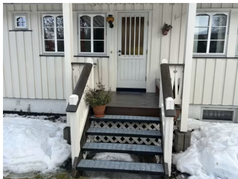
Terrasse ved inngangsparti.
