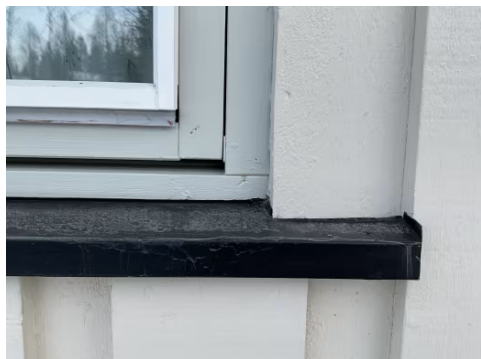
Utvendig listverket går helt ned til beslag.
