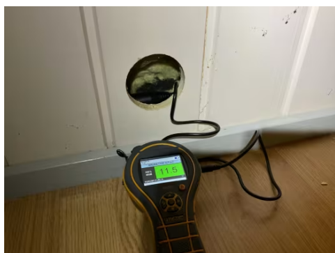
Hulltaking i utlektet vegg mot terreng.
