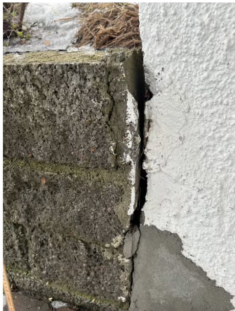
Utgledning av støttemur.
