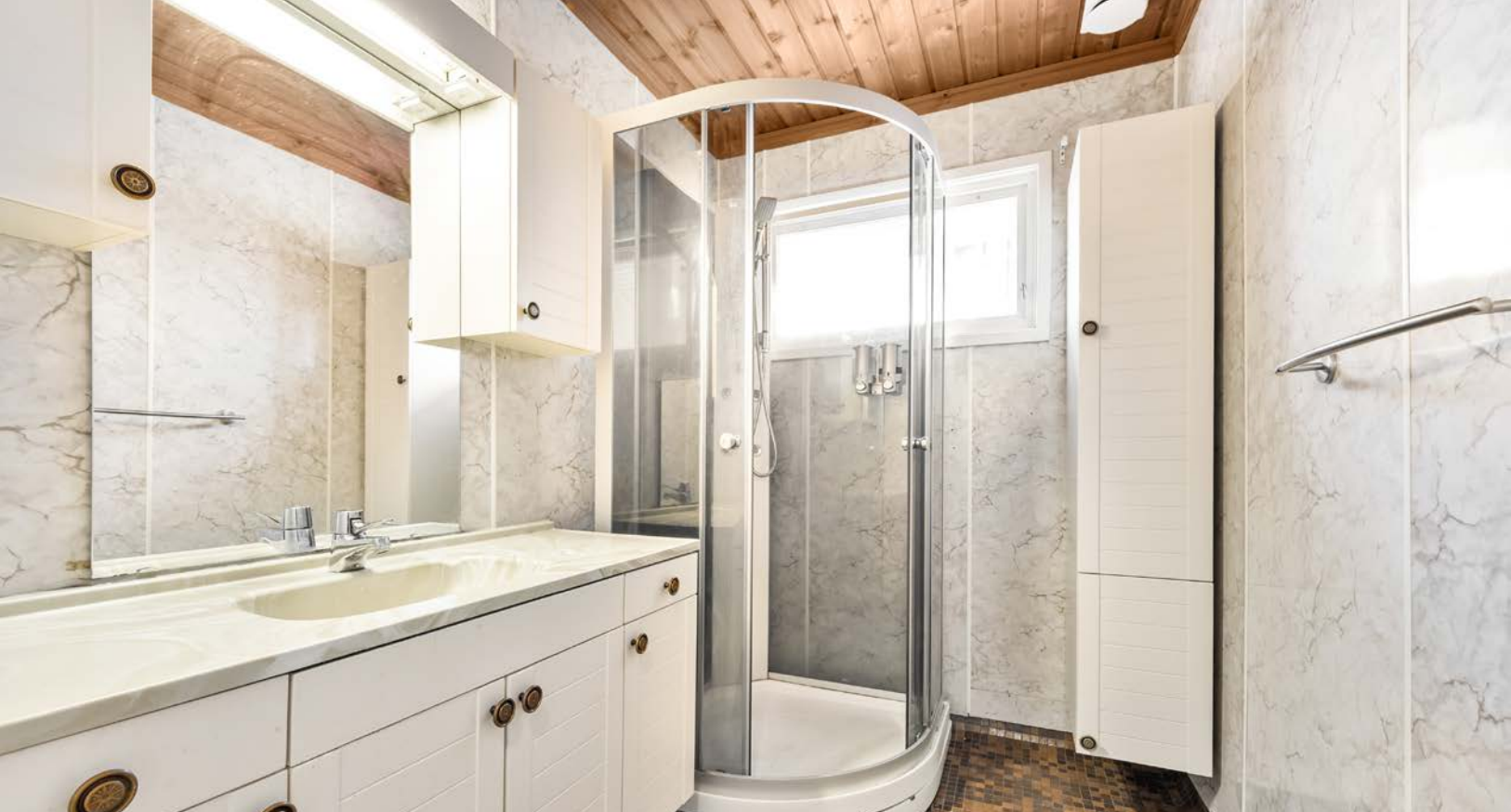
Boligens bad har fliser på gulvet med gulvvarme, mens det på veggene er våtromsplater. Videre har badet et nyere dusjkabinett.
