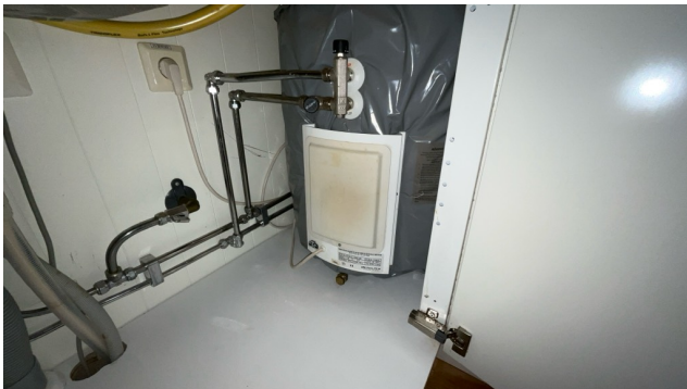
Besiktigelse av bereder.
