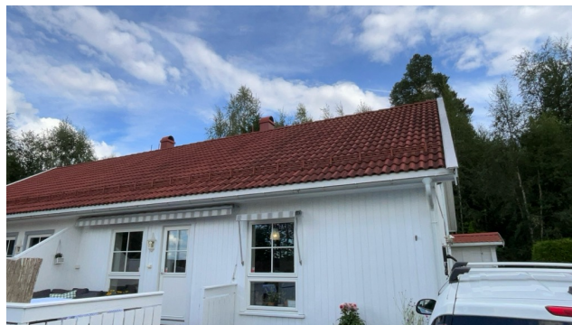
Besiktigelse av taktekke.
