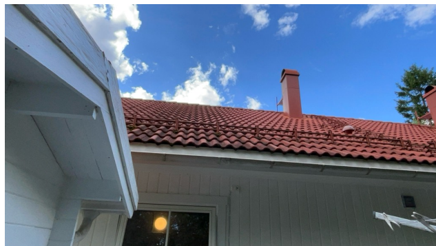
Besiktigelse av taktekke.
