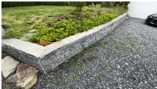
Besiktigelse av støttemur.
