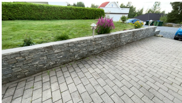
Besiktigelse av støttemur.
