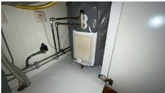
Besiktigelse av bereder.
