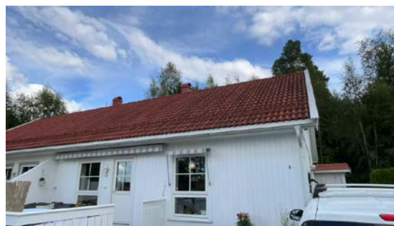
Besiktigelse av taktekke.
