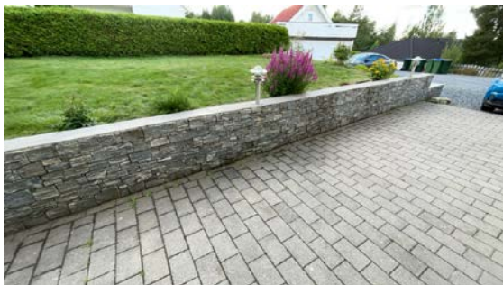
Besiktigelse av støttemur.
