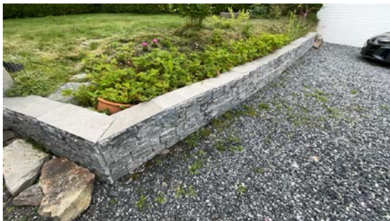
Besiktigelse av støttemur.
