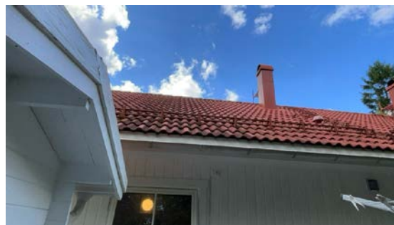
Besiktigelse av taktekke.
