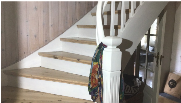
Trapp mellom 1 etg og loft
