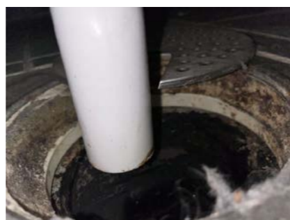
Sluk under kabinett.
