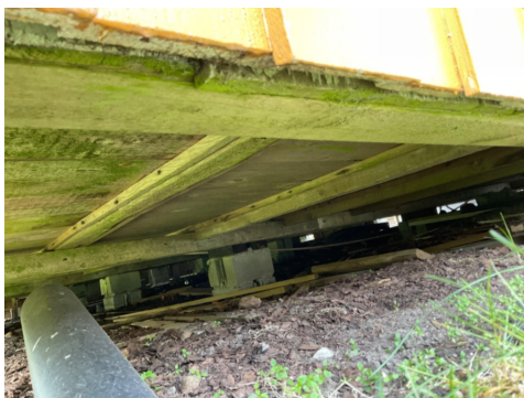
Fundamenterende under hytten
