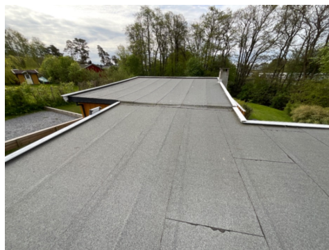
Takflate med asfaltapp
