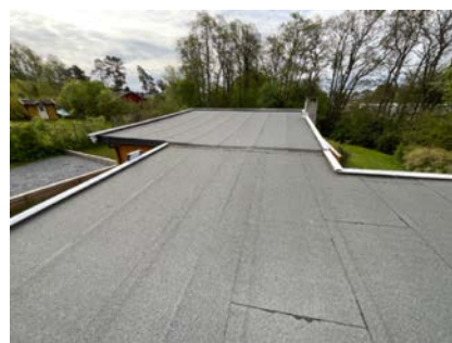
Takflate med asfaltapp
