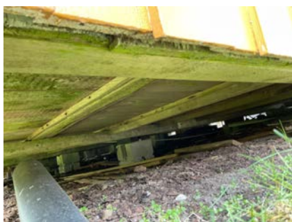
Fundamenterende under hytten
