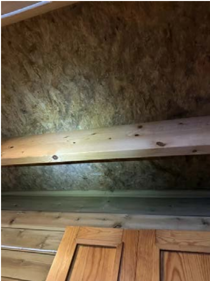
Misfarging tegn etter fukt/kondens i OSB i taket.
