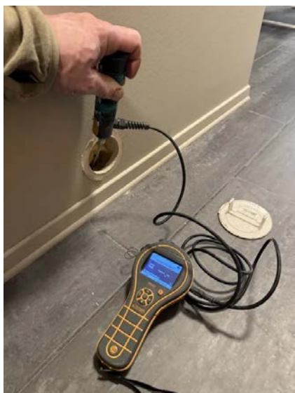
Det ble ikke registrert fukt ved hulltaking.
