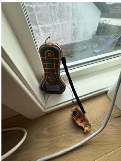
Vannlekkasje vindu stue 2.etasje.
