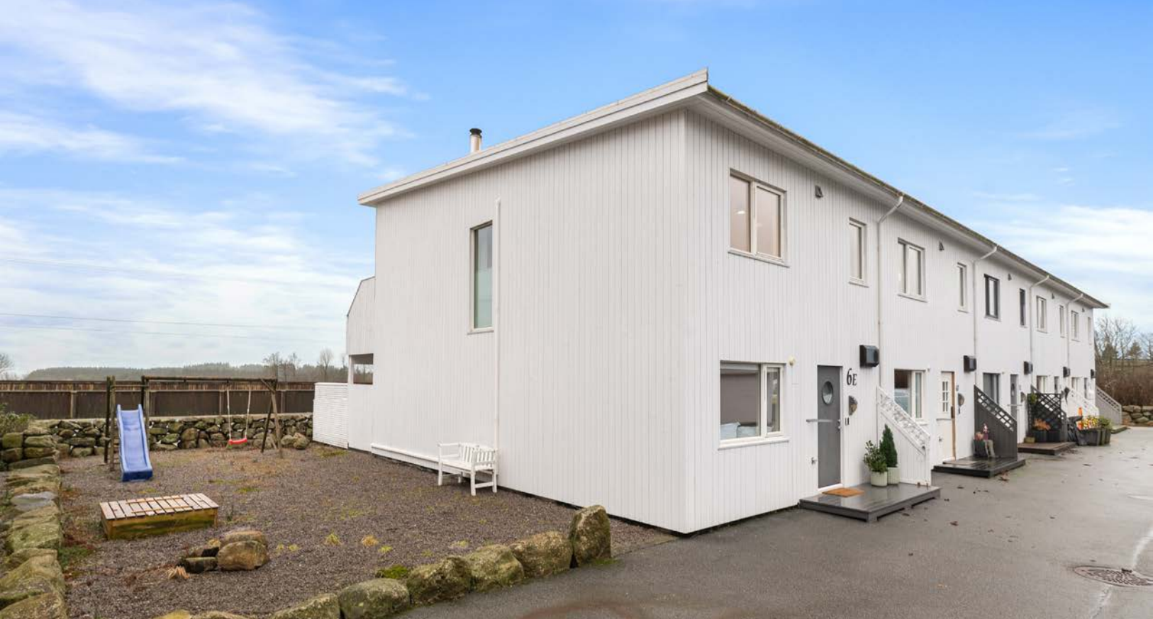
Enderekkehuset bærer god standard. Beliggende i motsatt ende av innkjørsel.
