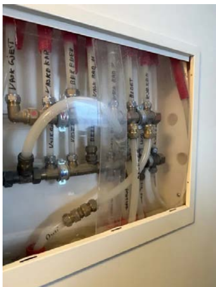
Rør er ikke isolert.
