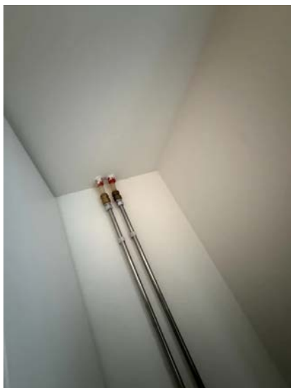
Rør er ikke isolert.
