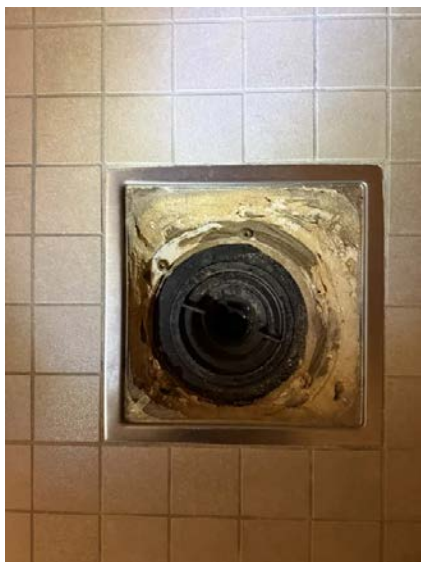
Membran er synlig ført under klemring i sluk.
