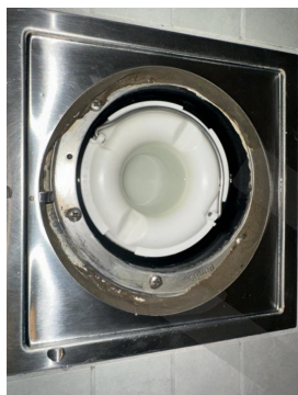
Plastsluk med klemring for membran
