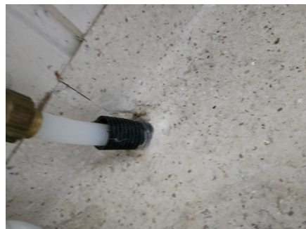
Rørgjennomføring i gulv.
