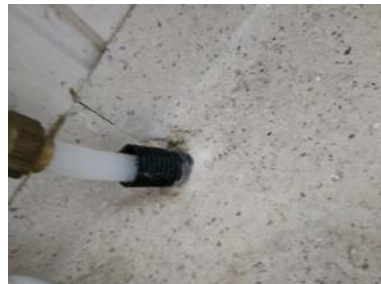
Rørgjennomføring i gulv.
