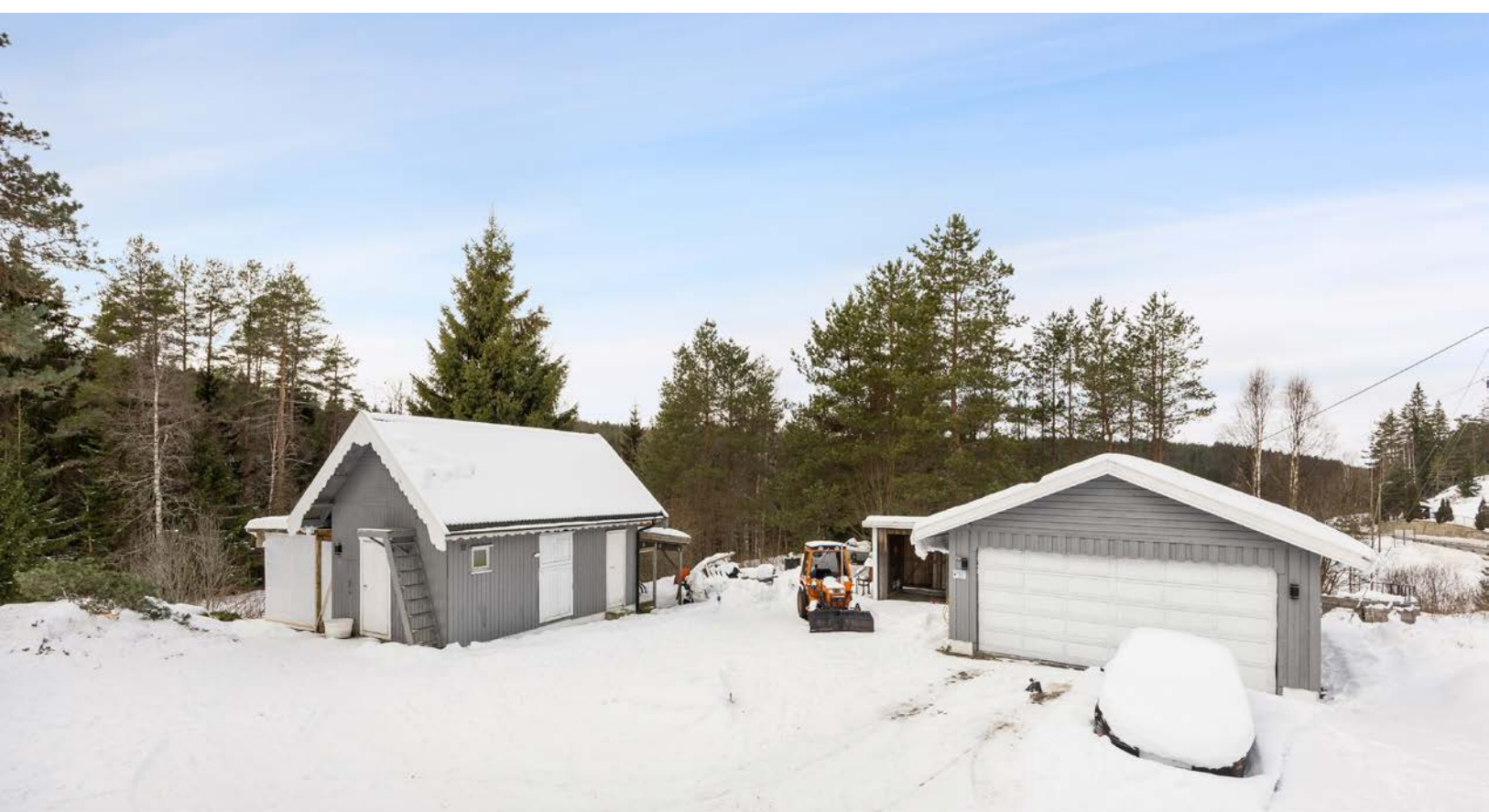
Det er parkering i en frittliggende dobbelgarasje på ca. 46 kvm og på en egen, gruslagt gårdsplass. Uthuset består av to rom samt et lagringsloft. Tilknyttet uthuset er det vedskjul og en hønsegård.
