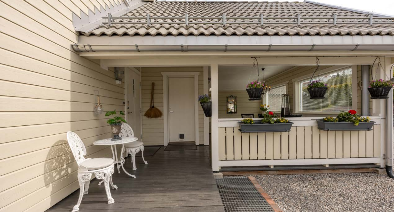
Overbygget uteplass ved inngangspartiet.
