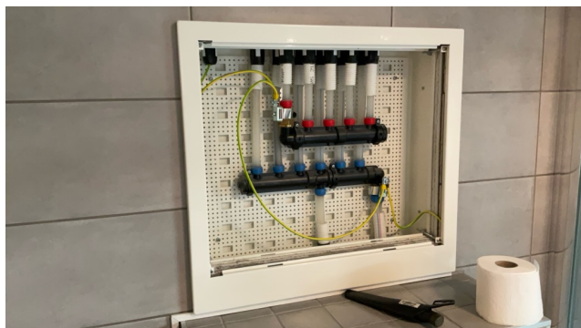
Fordelingsskap vannrør.
