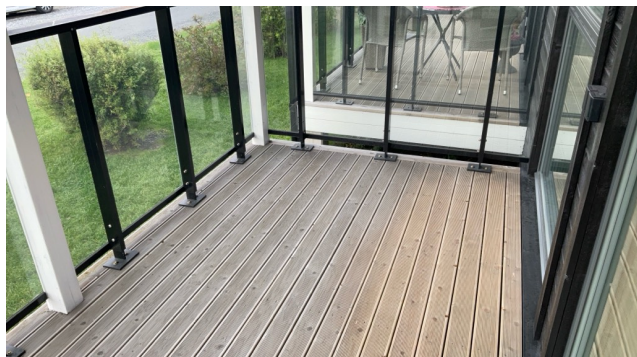
Terrasse med glassrekkverk.
