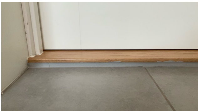
Spalte for tilluft under dør.
