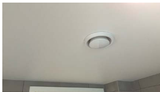
Avtrekk fra balansert ventilasjon.
