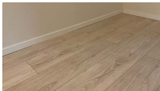
Åpninger mellom gulv og gulvlist.
