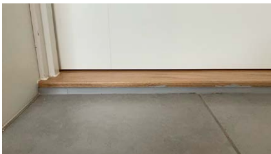
Spalte for tilluft under dør.
