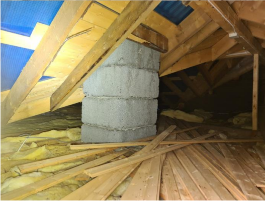
Kaldloftet i tilbygg.
