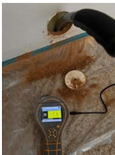
Fuktmåling i påført vegg mot grunnmur som ligger mot terreng.
