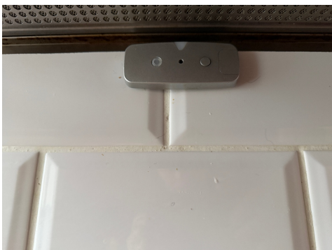
Komfyrvakt v/ kjøkkenventilator.
