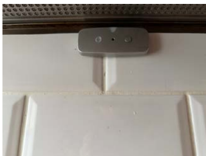
Komfyrvakt v/ kjøkkenventilator.
