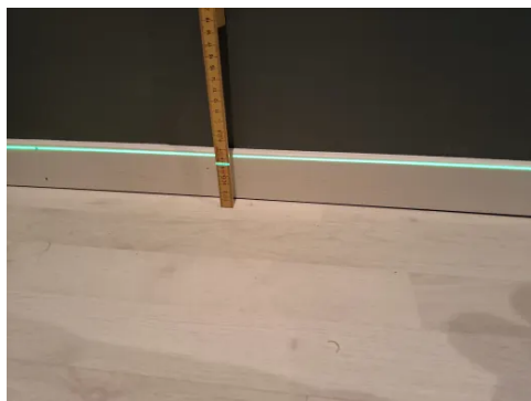
Etasjeskiller er kontrollert med nivelleringslaser.
