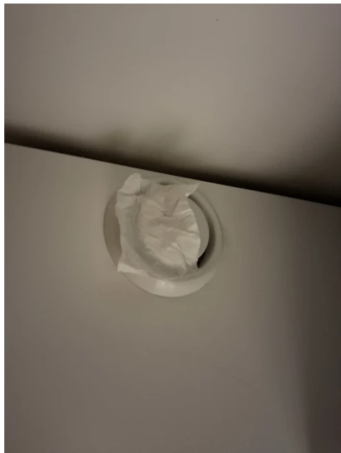
Avtrekkseffekten er testet med papir.
