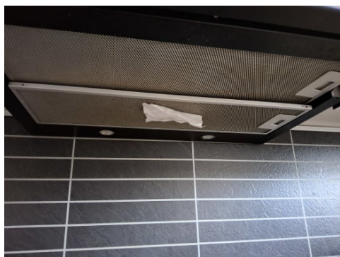
Avtrekkseffekt er testet med papir.
