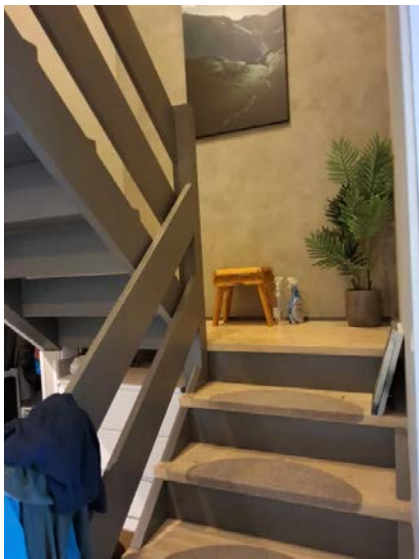
Lukket trapp av tre mellom etasjene,
