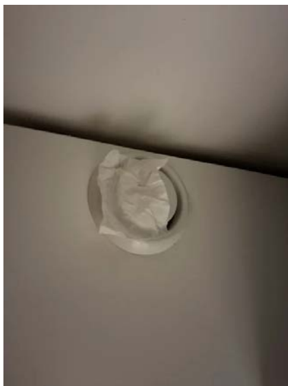
Avtrekkseffekten er testet med papir.
