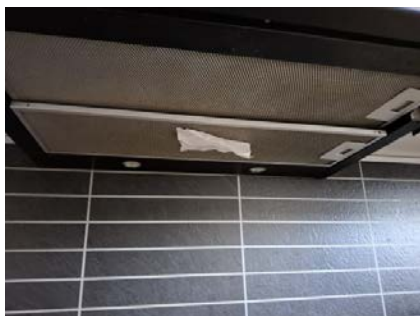
Avtrekkseffekt er testet med papir.
