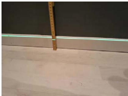
Etasjeskiller er kontrollert med nivelleringslaser.
