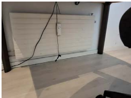
Leiligheten er oppvarmet med radiatorer.
