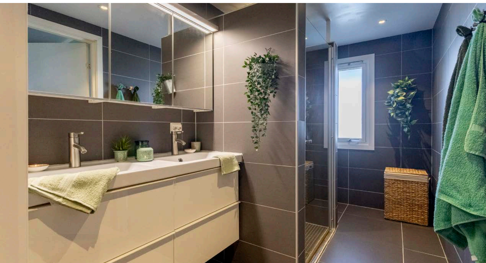
Flislagt bad med elektrisk varme i gulvet. Dusjnisse med dør og vegghengt dusjbatteri. Bak dusjen er det nisje med opplegg for vaskemaskin.
