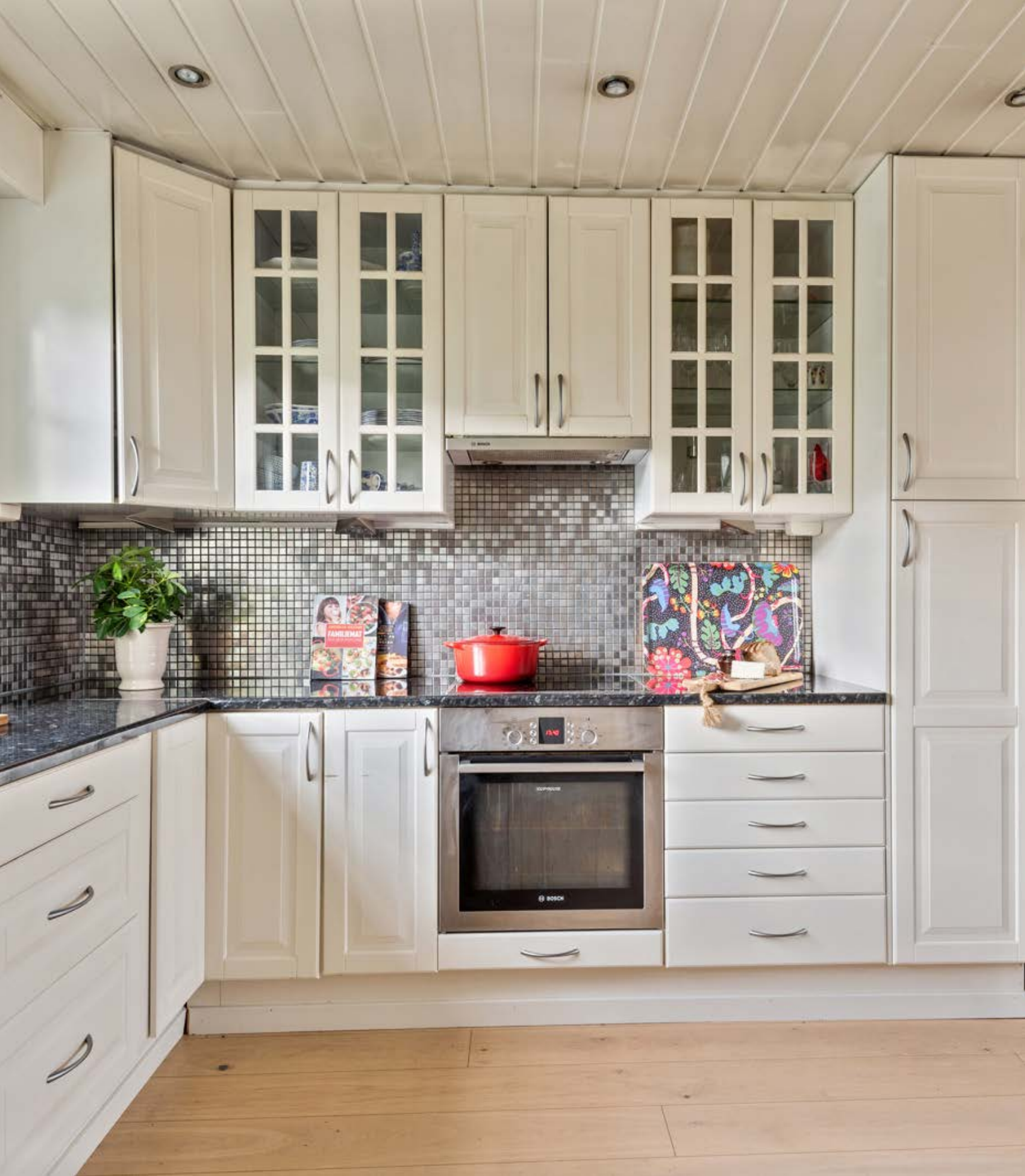
Innredning med lyse fronter og laminat benkeplate. Ventilator med utkast i yttervegg.
