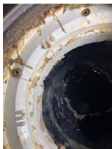
Synlig mansjett i sluk i dusjnise
