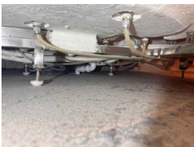
Sluk under badekar ikke tilgjengelig for kontroll
