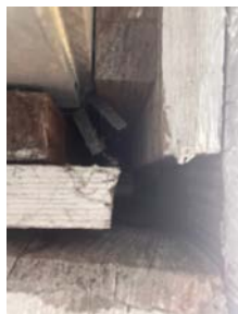
Mangler musesperre bak hjørnekasser.
