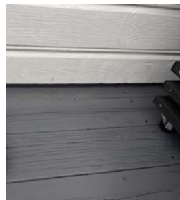
Kart avstand fra underkant kledning til terrassegulv
